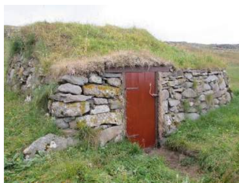
Mynd 21. Hesthúsið að lokinni viðgerð
